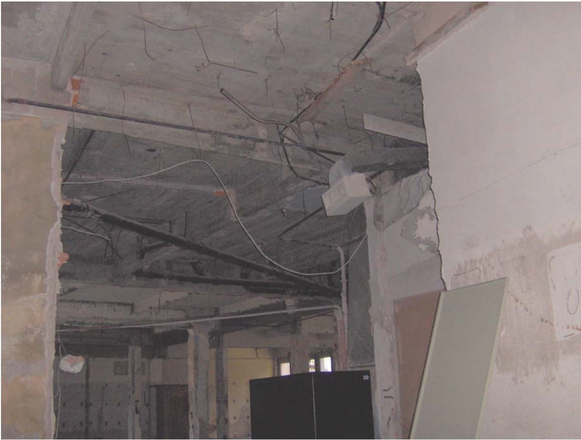
Foto N° 21 – Demolición del cuarto piso.
