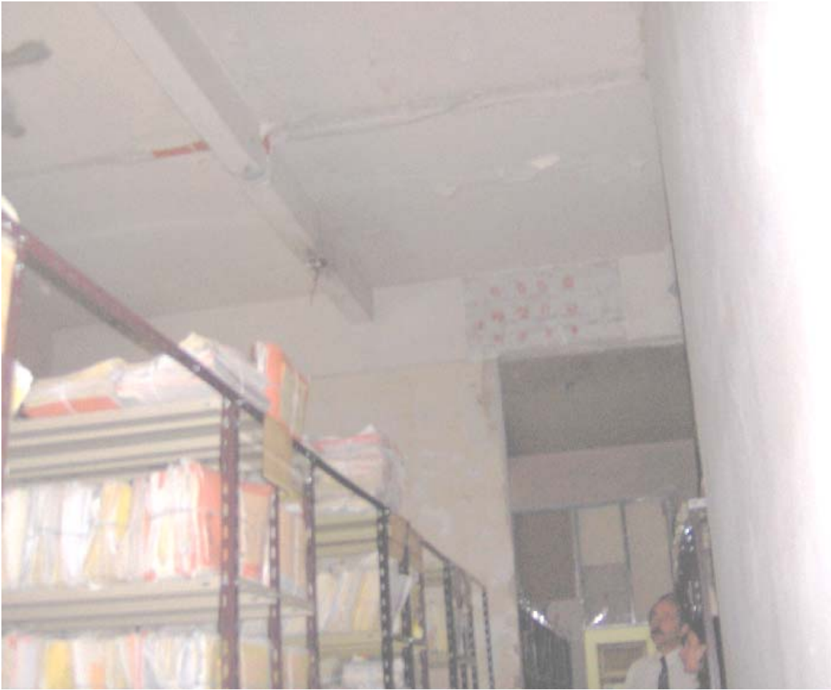
Foto N° 33 – Foto que muestra el mismo motivo de la foto N° 32.
