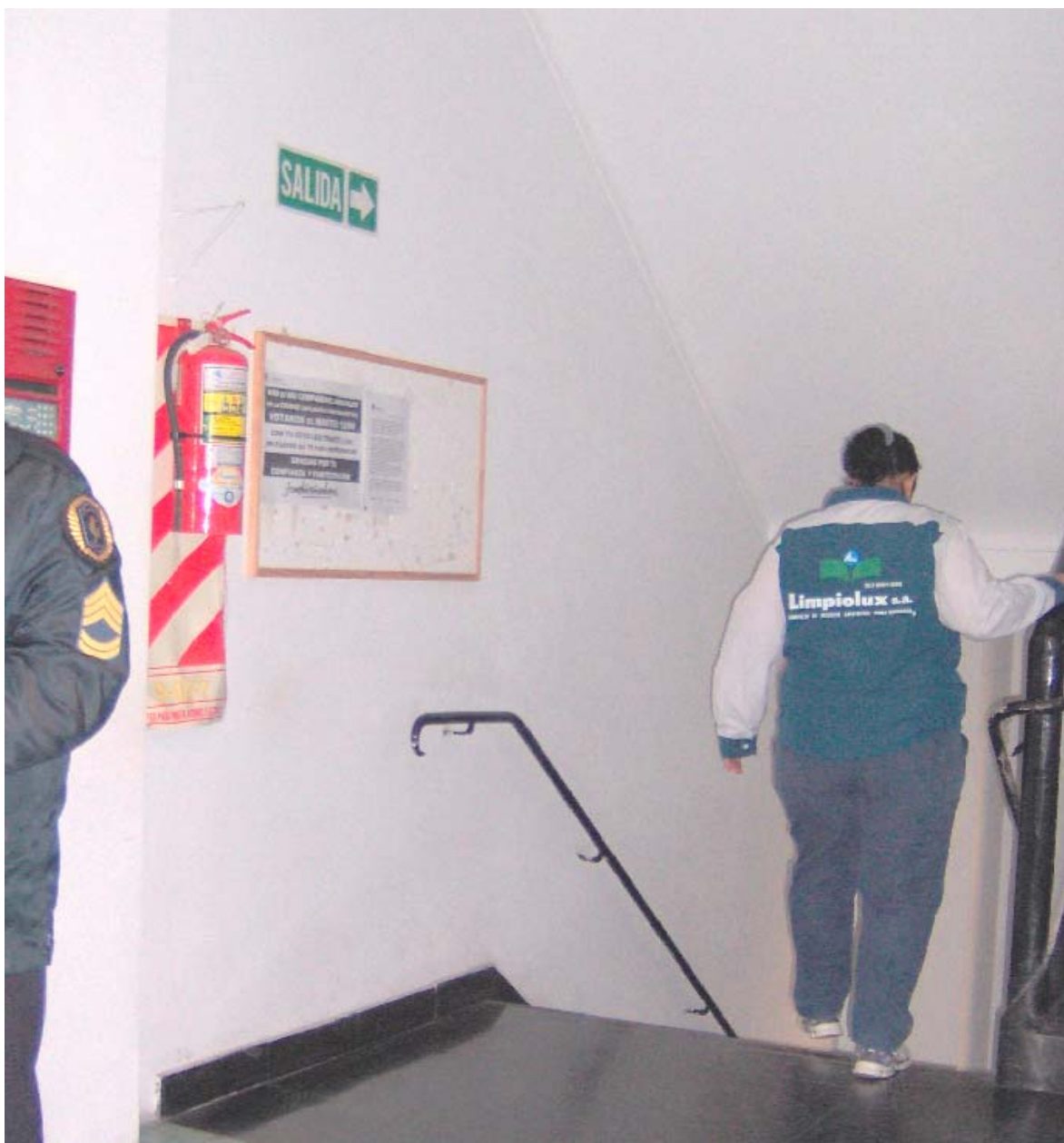
Foto N° 5 – En el descanso de escalera del primer piso se puede observar sobre la pared el matafuegos y un cartel indicador de salida.
