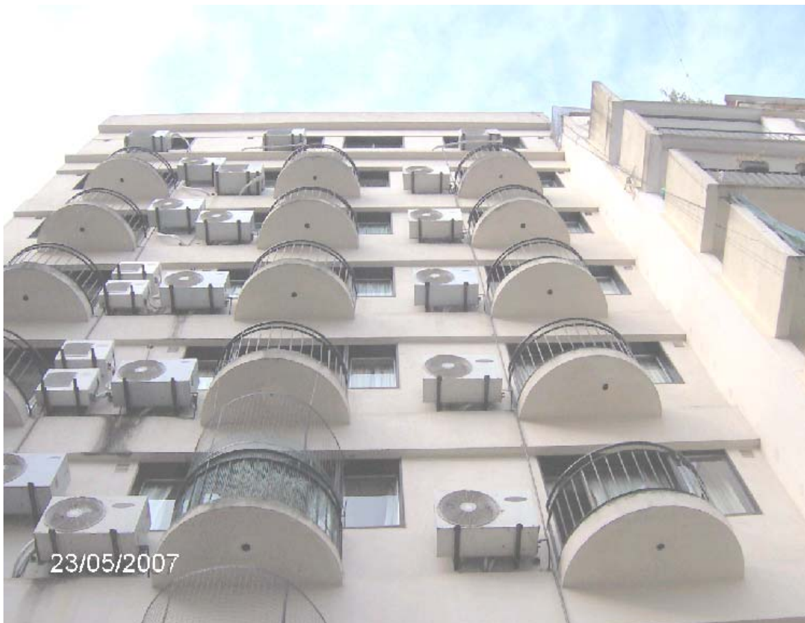
Foto N° 17 – En la presente toma de la pared del contrafrente se pueden apreciar los balcones de cada oficina y al costado los compresores de los equipos de aire acondicionado split, en el primer piso el balcón tiene un tejido de protección pues a ese lugar concurren niños.
