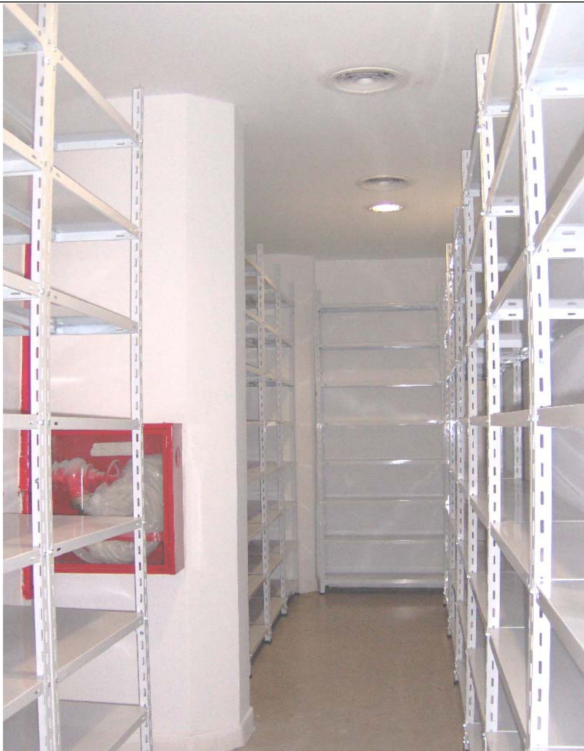
FOTO N° 6 – LOCAL DE ARCHIVO CON ESTANTERÍAS METÁLICAS FIJADAS EN EL PISO Y EL TECHO, TIENE UNA CABINA PARA MANGUERA CONTRA INCENDIO EN UNA PARED Y EN EL CIELORRASO LOS ARTEFACTOS DE ILUMINACIÓN EMBUTIDOS Y LAS BOCAS DE SALIDA DEL SISTEMA DE AIRE ACONDICIONADO CENTRAL.
