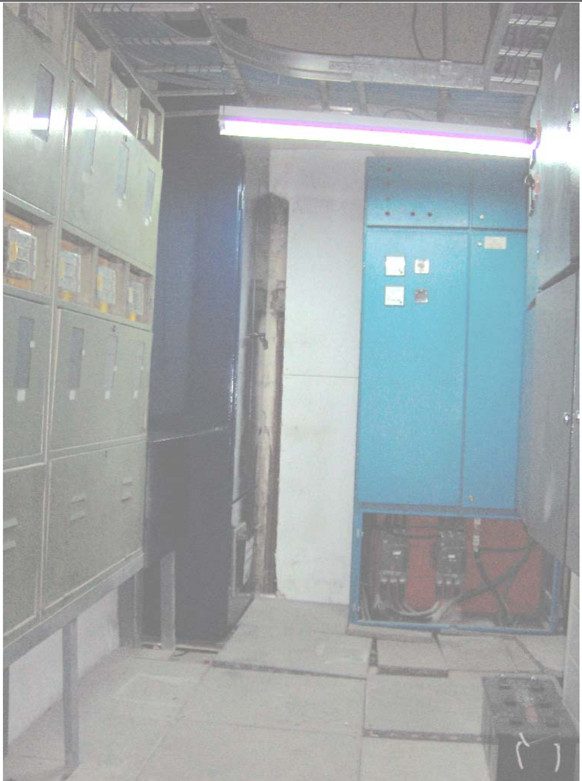
FOTO N° 14 – SALA DE UPS CON EL PISO TÉCNICO (EN CONSTRUCCIÓN).
