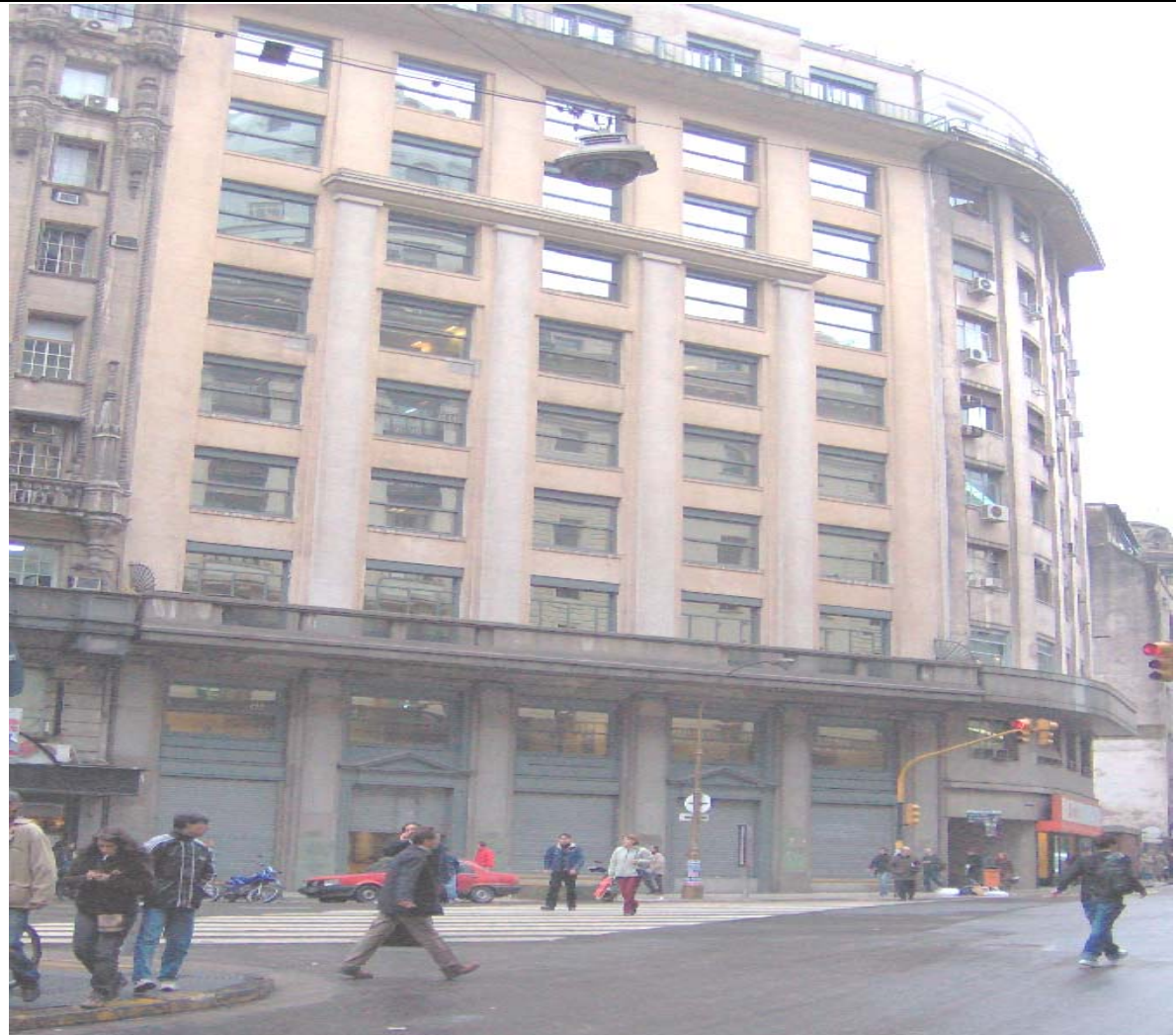
FOTO N° 2 – NUEVO SEDE DEL CONSEJO DE LA MAGISTRATURA – JUSTICIA CONTENCIOSO ADMINISTRATIVO Y TRIBUTARIO DE LA AV. R. S. PEÑA 636, EDIFICIO RECICLADO CON SALA DE UPS Y CON TABLEROS, EN EL SUBSUELO GENERADOR DE CORRIENTE ELÉCTRICA DIESEL. LOS MATAFUEGOS SON CONTROLADOS POR UNA EMPRESA DEL RAMO, UN TABLERO DE LA CENTRAL DE INCENDIOS MANEJA EL SISTEMA DE TODO EL EDIFICIO. EN TODAS LAS OFICINAS HAY CIELORRASO ARMADO Y PISO TÉCNICO POR DONDE PASAN LAS CAÑERÍAS Y CABLEADO DE TODOS LOS SISTEMAS (AGUA CONTRA INCENDIO, ELECTRICIDAD, SISTEMAS, ETC).
