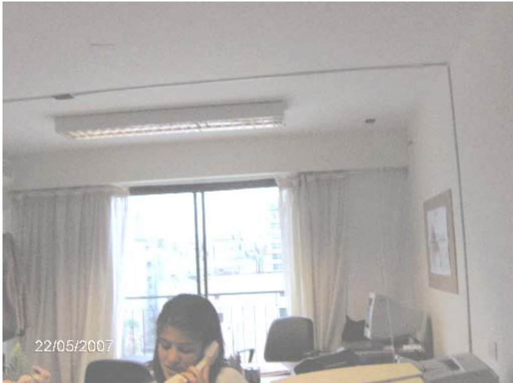
Foto N° 1 – Oficina del 8° piso al frente – se puede observar que parte de la instalación eléctrica es exterior (por cablecanal), producto de la improvisación en el reciclado de este edificio.
