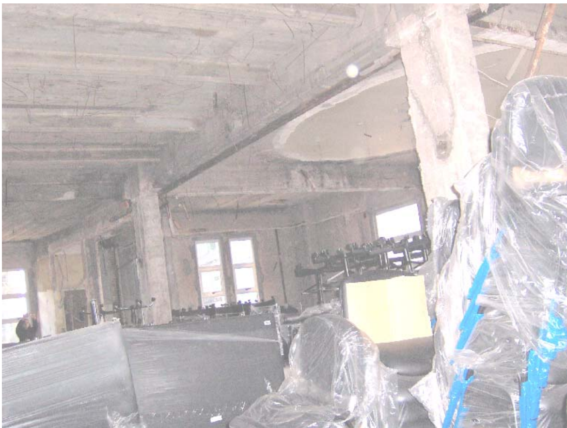
Foto N° 22 – Demolición del cuarto piso y elementos de oficina (sillones) depositados en este lugar.
