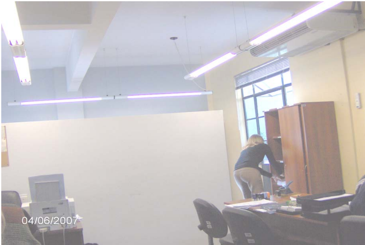
Foto N° 2 – Oficina de la fiscalia con escritorios muebles y artefactos de iluminación, las divisiones como la del fondo de la foto de color claro fueron realizadas en Durlock, que no llegan al techo para poder ser iluminadas y ventiladas por ventanas en común.
