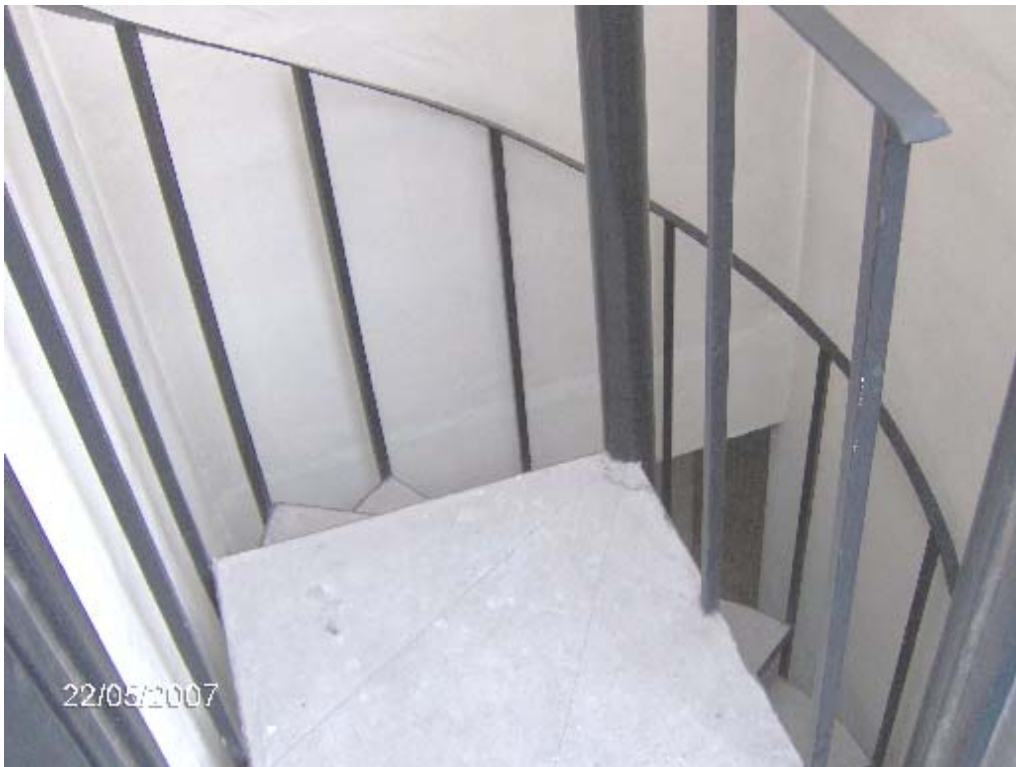
Foto N° 5 - Salida a la terraza donde se puede apreciar en detalle la escalera tipo caracol de herrería que sube desde el nivel del 9° piso.
