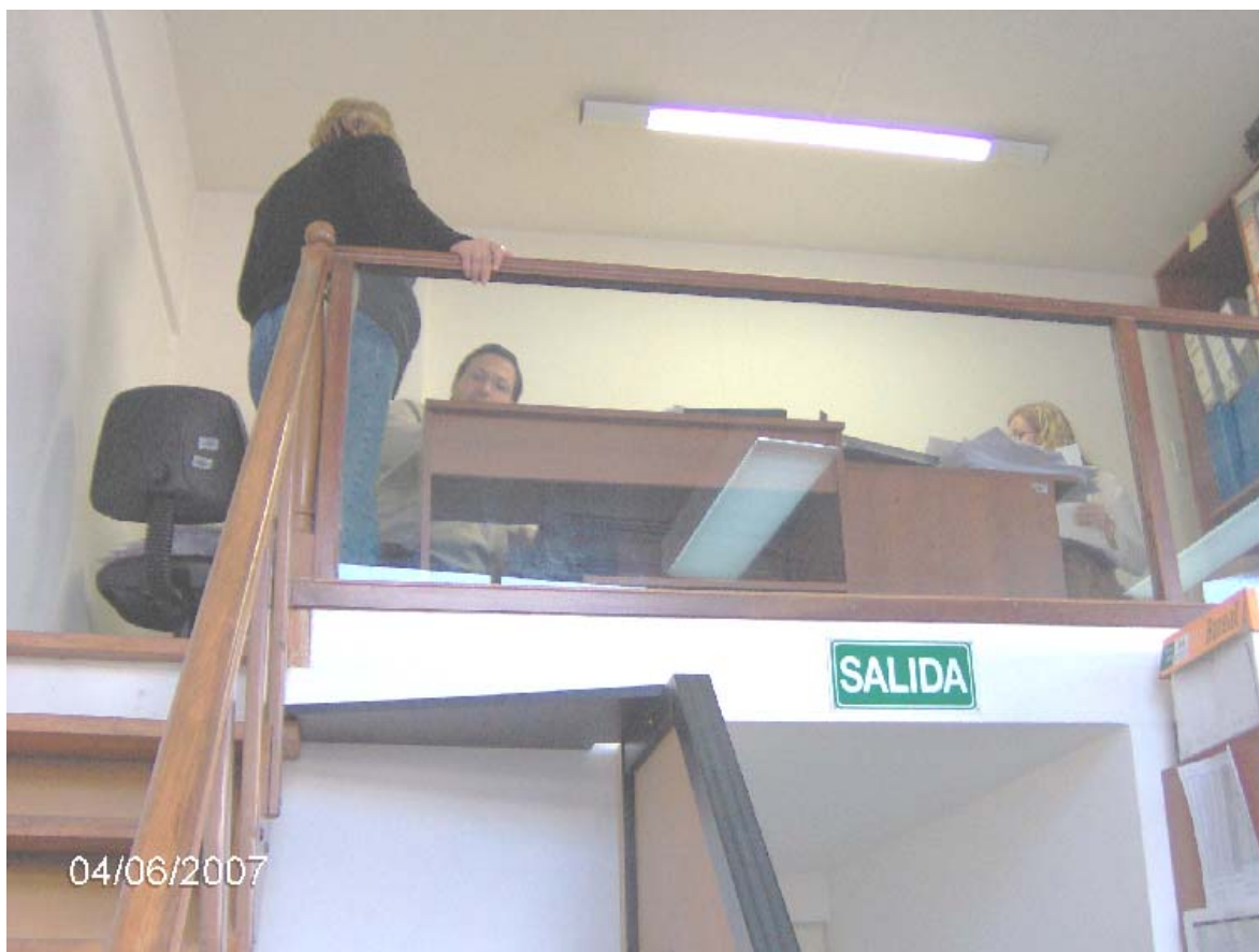
FOTO N° 5– OFICINA DE LA FISCALIA EN LA PLANTA BAJA CON ESCRITORIOS Y MUEBLES EN UN ENTREPISO DE 2,30 M DE ALTURA, ES DE NOTAR QUE ESTA ESCALERA DE 60 CM DE ANCHO NO ES REGLAMENTARIA PARA UN EDIFICIO DE OFICINAS, DEBIERA SER DE 1 M DE ANCHO (CE 4.7.5.1) Y LA BARANDA QUE SE VE AL FRENTE DEL MISMO NO PRESENTA SUFICIENTE SEGURIDAD PUES LE FALTAN PARANTES.
