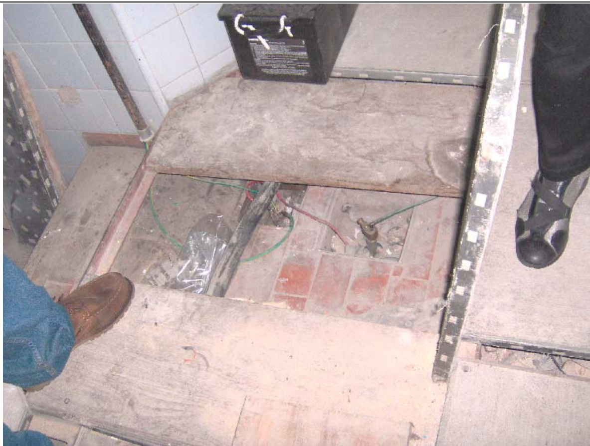
FOTO N° 11 – DETALLE DEL PISO TÉCNICO EN LA SALA DE UPS EN CONSTRUCCIÓN.
