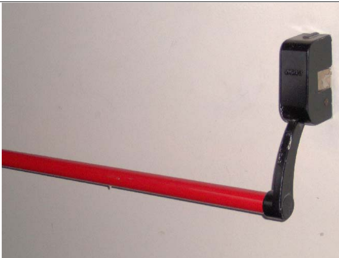
FOTO N° 21 – PUERTA CON MANJÓN DEL SISTEMA DE SEGURIDAD EN LA SALIDA DE EMERGENCIA.
