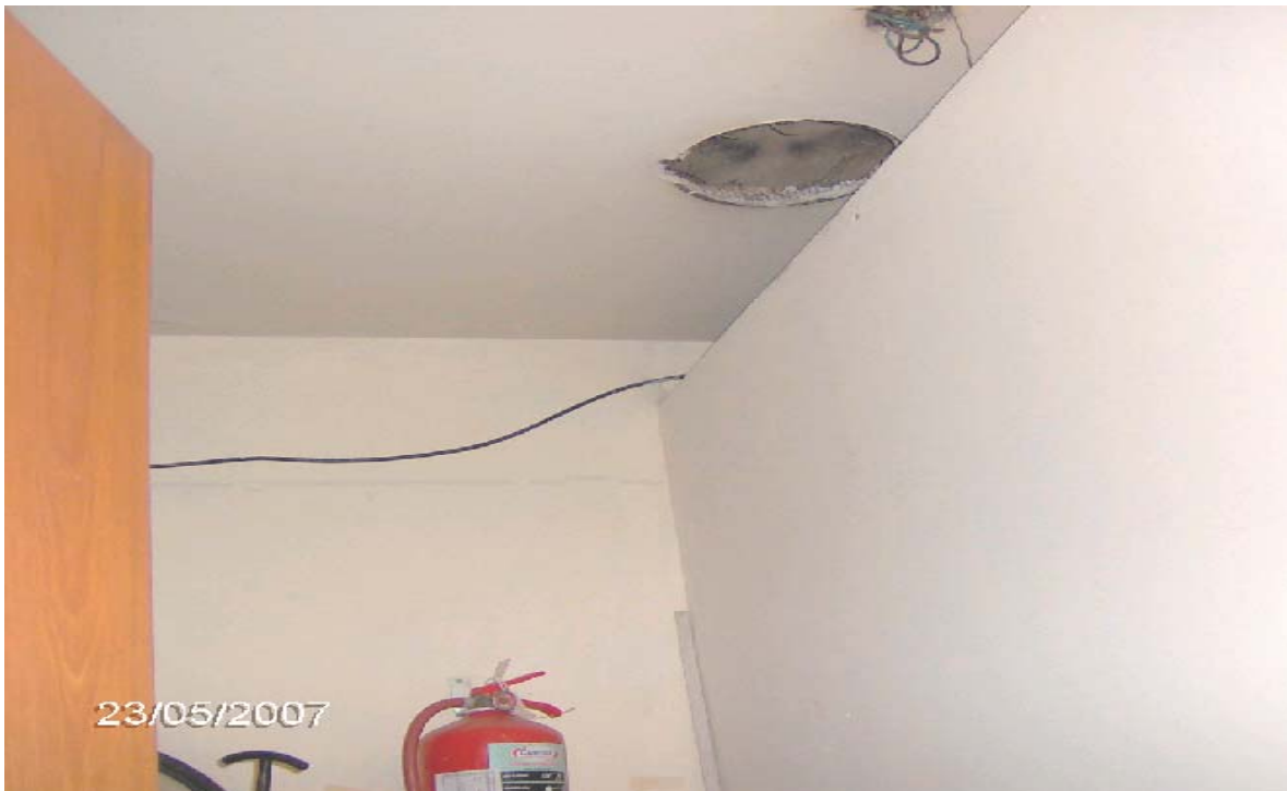
Foto N° 26 – En planta baja en un local-depósito, base de mantenimiento, detrás de la recepción se pueden observar en el cielorraso dos bocas de iluminación sin tapa y con cables expuestos y encintados.
